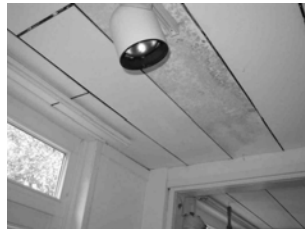
Feuchtigkeitsschäden Decke
